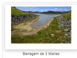
Barragem de 3 Marias
